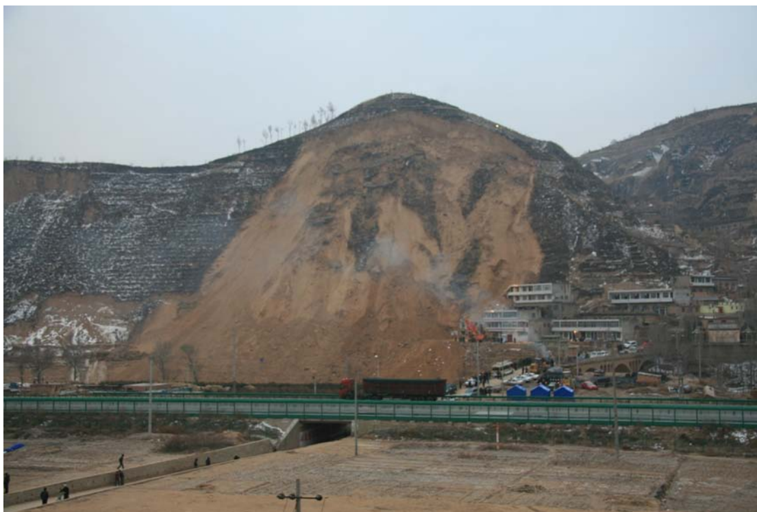
照片1 陕西省子洲县双湖峪镇石沟村黄土崩塌全貌
